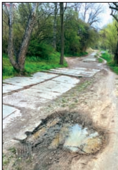
Stav před rekonstrukcí
