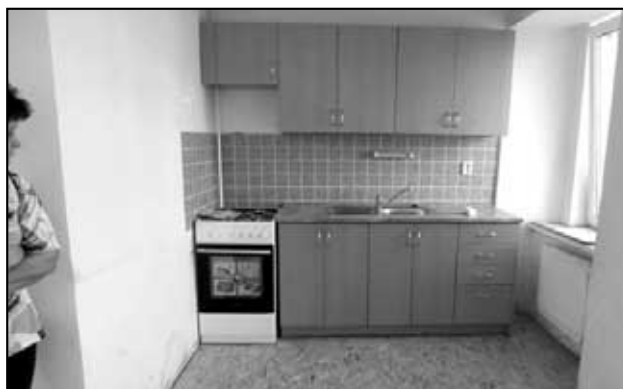
Opravené byty po povodních v čp.56
