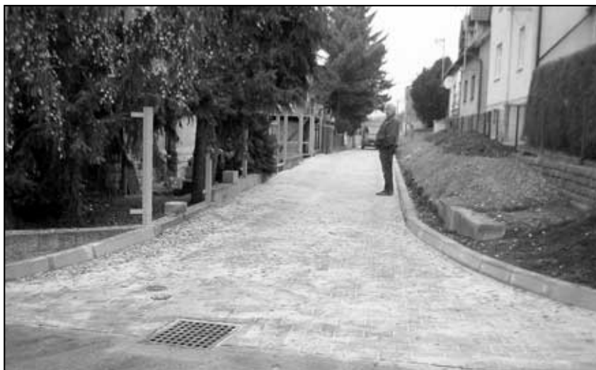
Oprava komunikace nad školou.
