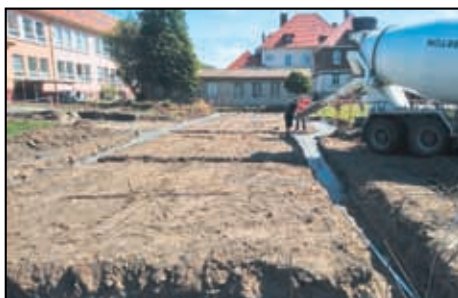
Betonování základů nové mateřské školky
