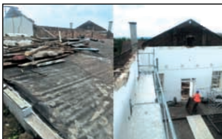
Pohled shora: obr1. střeš výčepu
