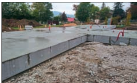
Finální základová deska
