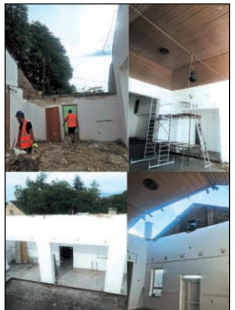
Probíhající demontáž střechy sálu
