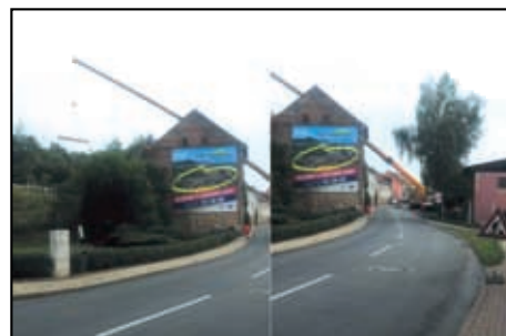
Materiál na stavbu střeš musel dopravit jeřáb s ramenem dlouhým 21m.
