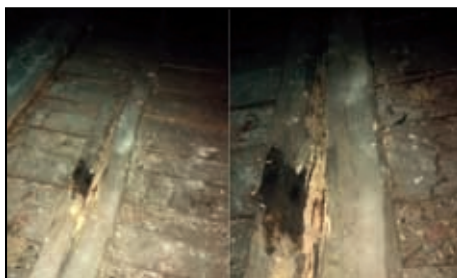
Hniloba nosného trámu
