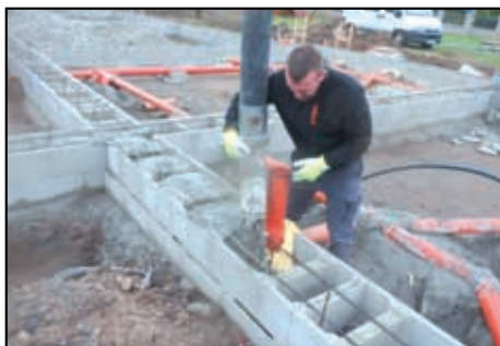
Rozvod odpadů a betonování ztraceného bednění
