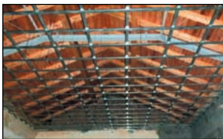
Na obrázku je vidět železná nosná konstrukce střešy. Příprava na zateplení a sádkokarton
