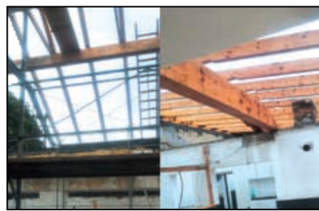
Stavba nových krovů
